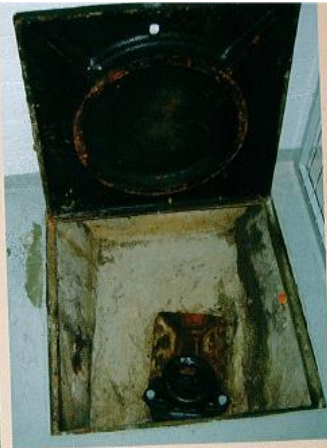
Korjattu ja huollettu viemärin sulkuventtiili.
